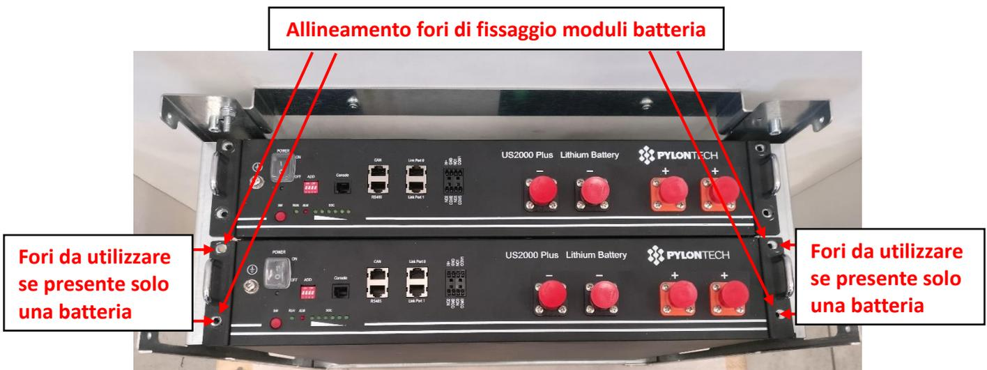
Figura 8 - Alloggiamento moduli batteria (se pervisti 2 moduli dalla dotazione)
