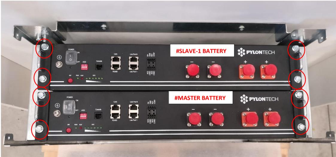
Figura 10 – Fissaggio moduli batteria al box batteria
