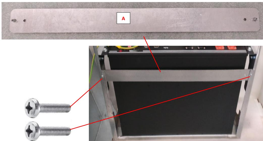
Figura 25 – Installazione staffa segregazione batterie sul WALL-BOX-Bx BASE
