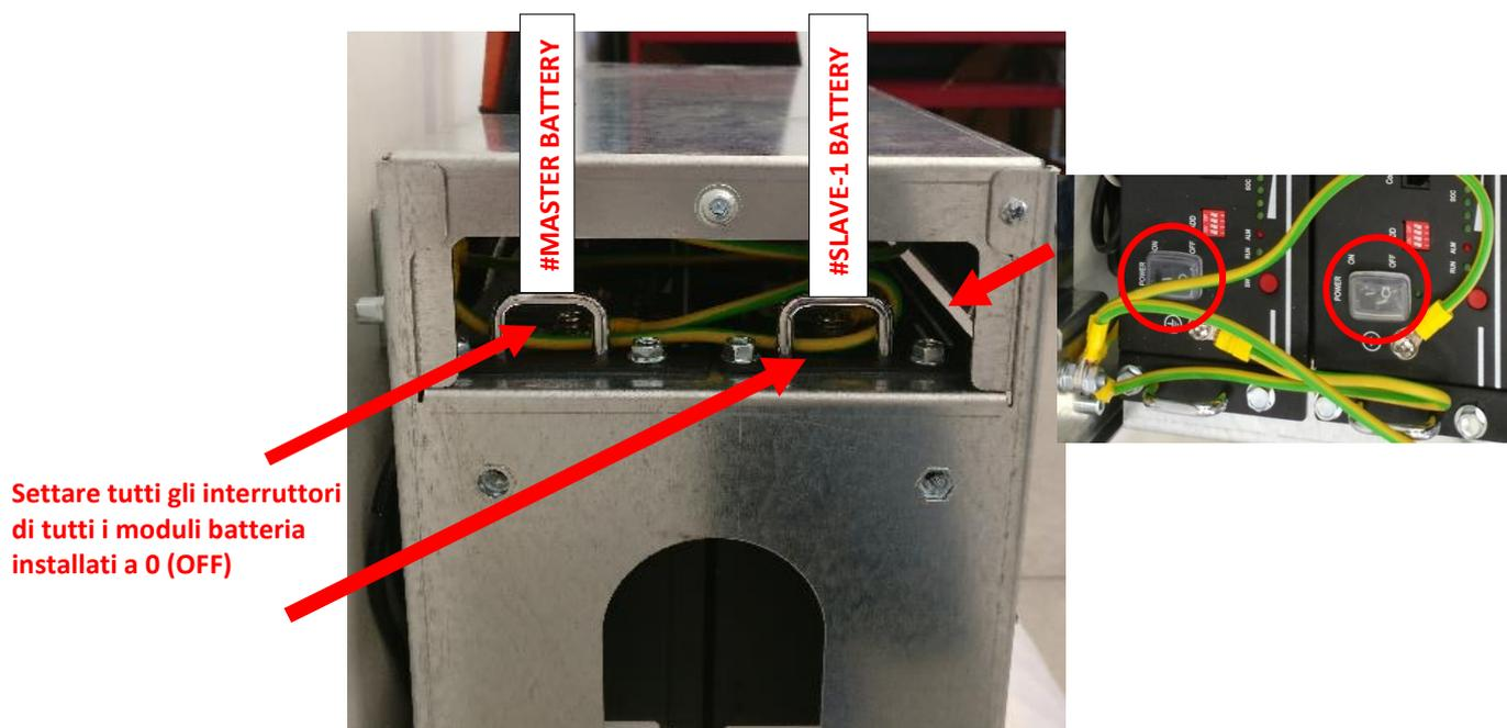
Figura 82 – Posizionare su "0" tutti gli interruttori di tutti i moduli batteria installati sul sistema di accumulo
