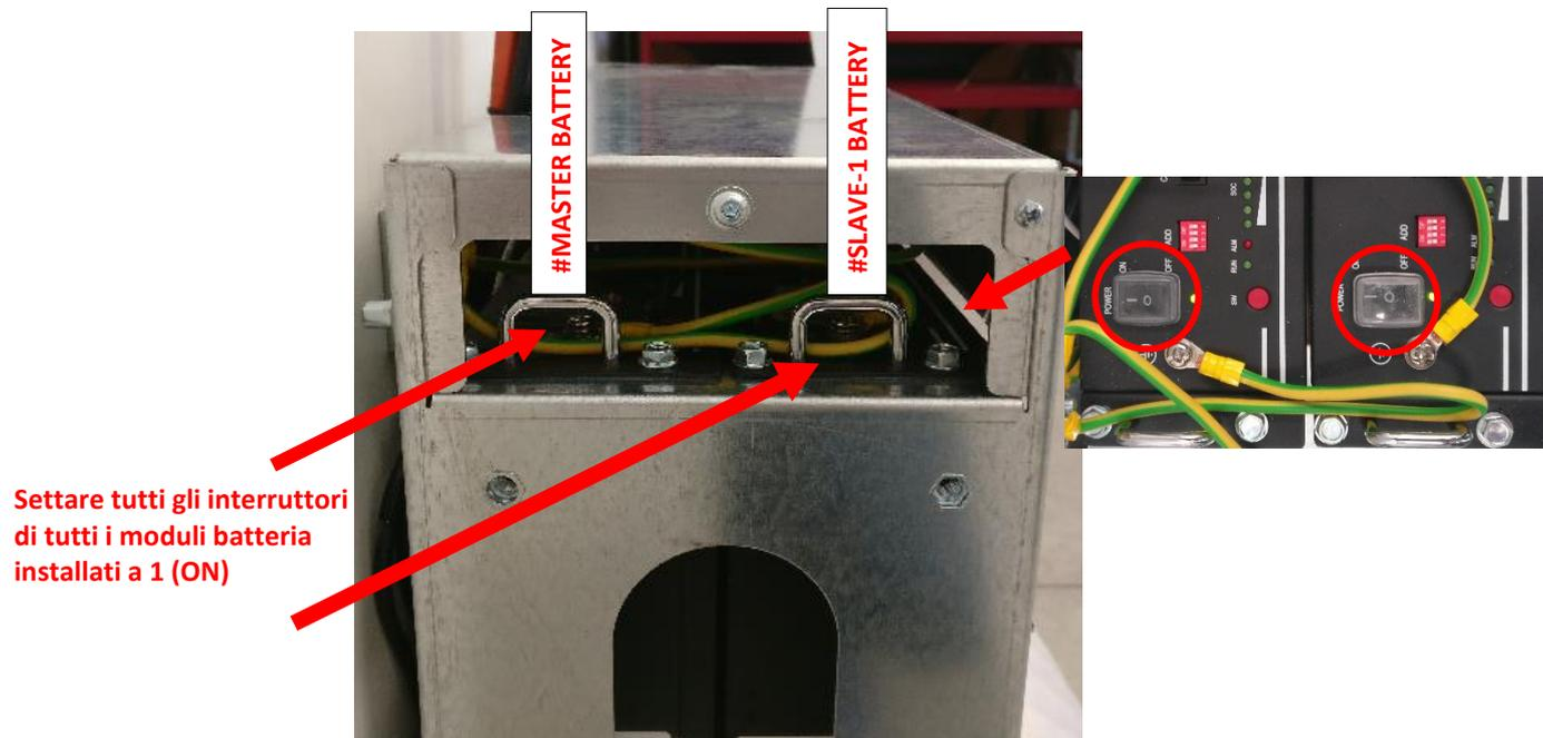
Figura 83 – Posizionare su "1" tutti gli interruttori di tutti i moduli batteria installati sul sistema di accumulo
