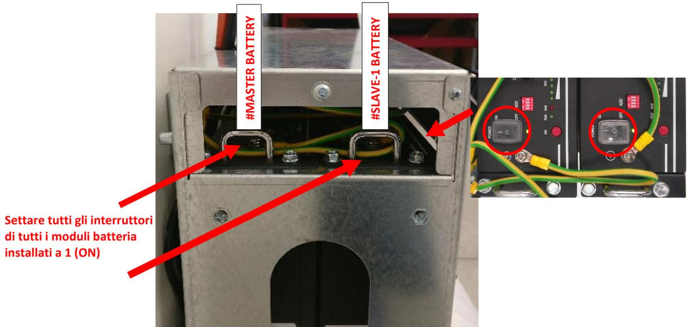
Figura 55 – Posizionare su “1” tutti gli interruttori di tutti i moduli batteria installati sul sistema di accumulo
