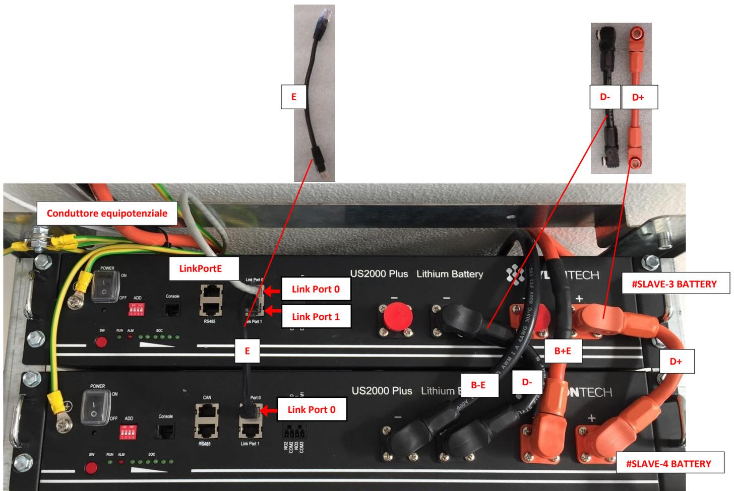
Figura 33 – I collegamenti necessari sul WALL-BOX-Bx ESPANSIONE
