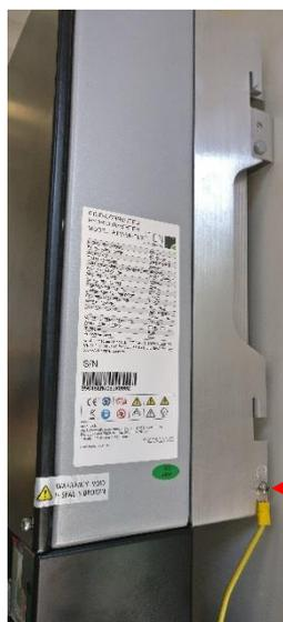
**VITE DA UTILIZZARE PER COLLEGARE LA MASSA DEL DISSIPATORE ALLA MASSA DELLA MACCHINA. CAVO GIALLOVERDE IN DERIVAZIONE DAL NODO DI TERRA DELLA MACCHINA**
